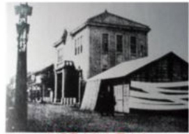
京橋月島警察署庁舎
