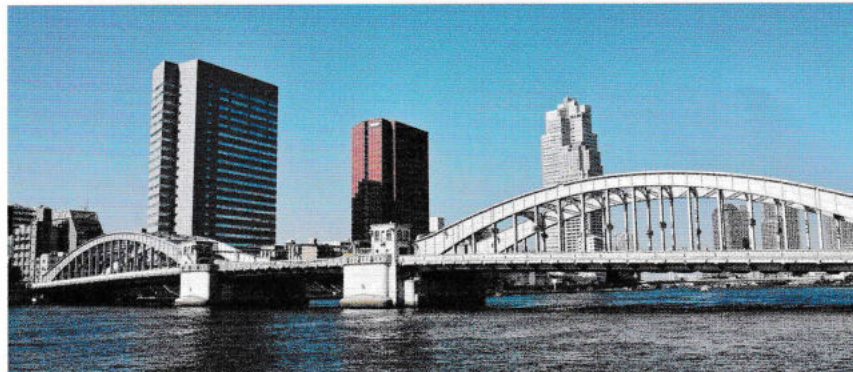
可動部は70度まで70秒で開き、その間、晴海通りは20分間通行止めになりました。1970年11月29日を最後に開閉を中止。しかし、現在でも動かせるように、機械のメンテナンスは行われています。『勝鬨橋』中央区立京橋図書館所蔵
